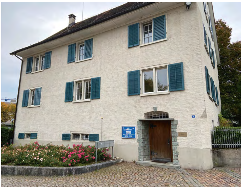
Wohnungssanierung im alten Pfarrhaus, Kirchgasse 4
